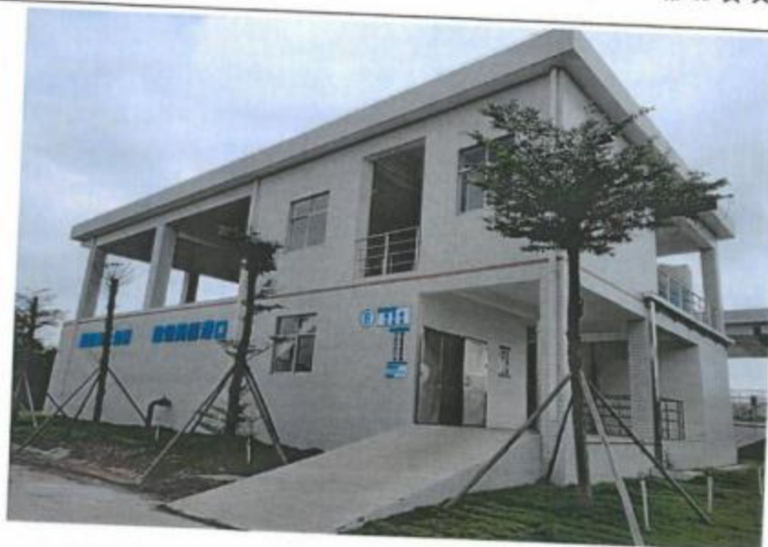
图 3-3 磁混凝沉淀池
