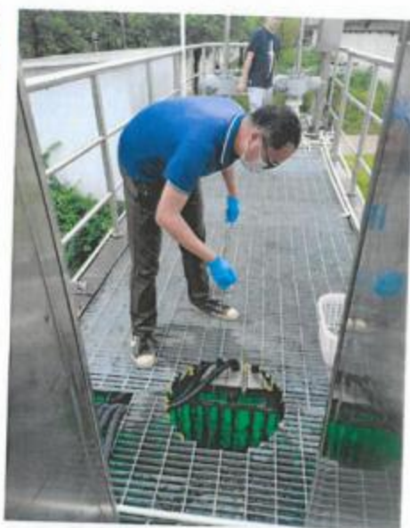
城镇污水排放口 (WS-05898)
