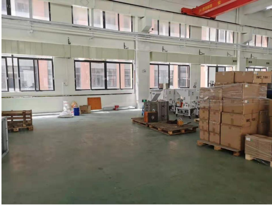
图3 项目厂区地面硬化图
