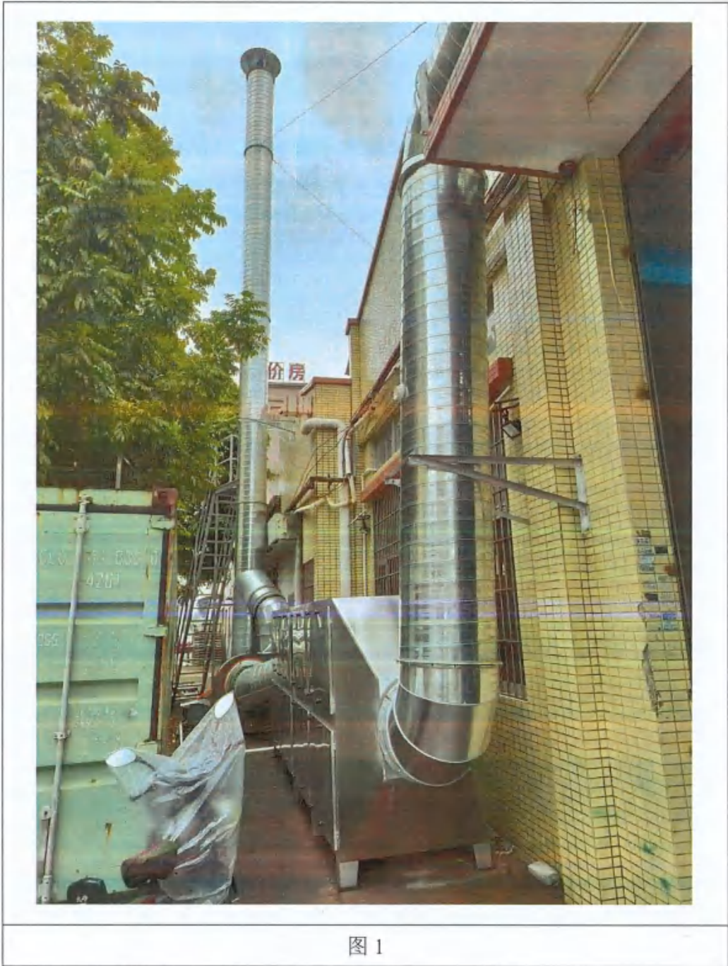
附图 3：废气治理设施及排气筒照片
