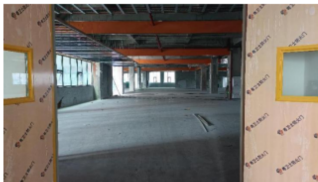
图 3 项目厂区地面硬化图
