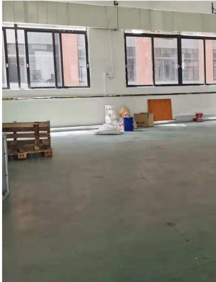
图 4 项目厂区地面硬化图
