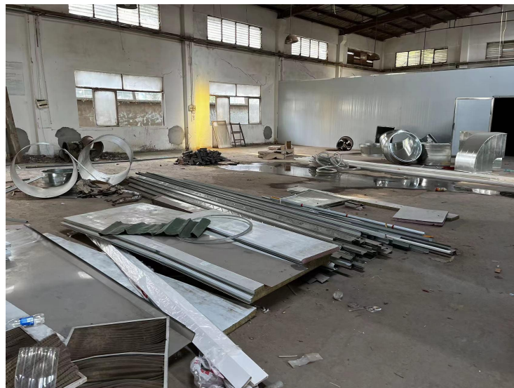
图 3 建设项目现场图
