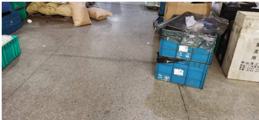
图 3 项目厂区地面硬化图
