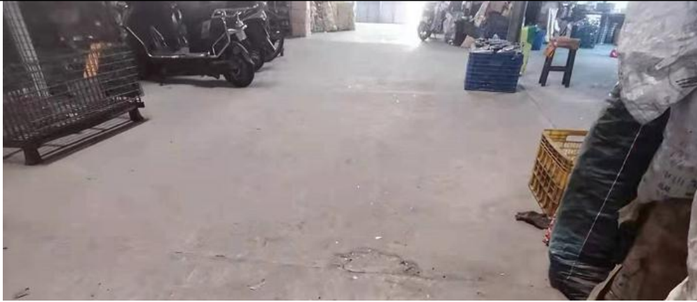
图 3 项目厂区地面硬化图
