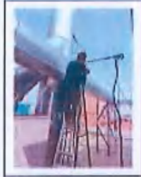
自动喷涂线C废气G1处理前
