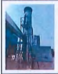
手动喷涂线e废气G4排放口
