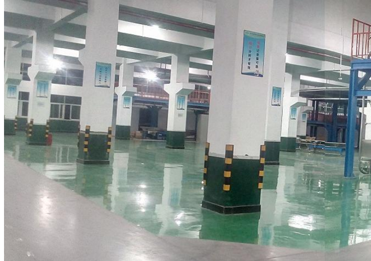
图 3 项目厂区地面硬化图
