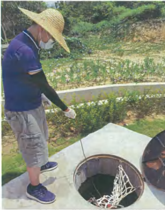
生活污水及垃圾渗滤液收集池
