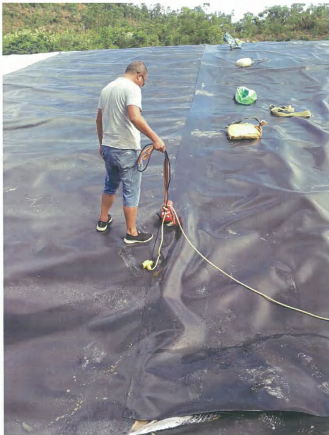
图 3-9 施工现场焊接 HDPE 膜
