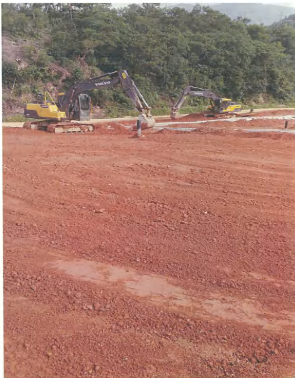
图 3-10 施工现场覆盖黏土层
