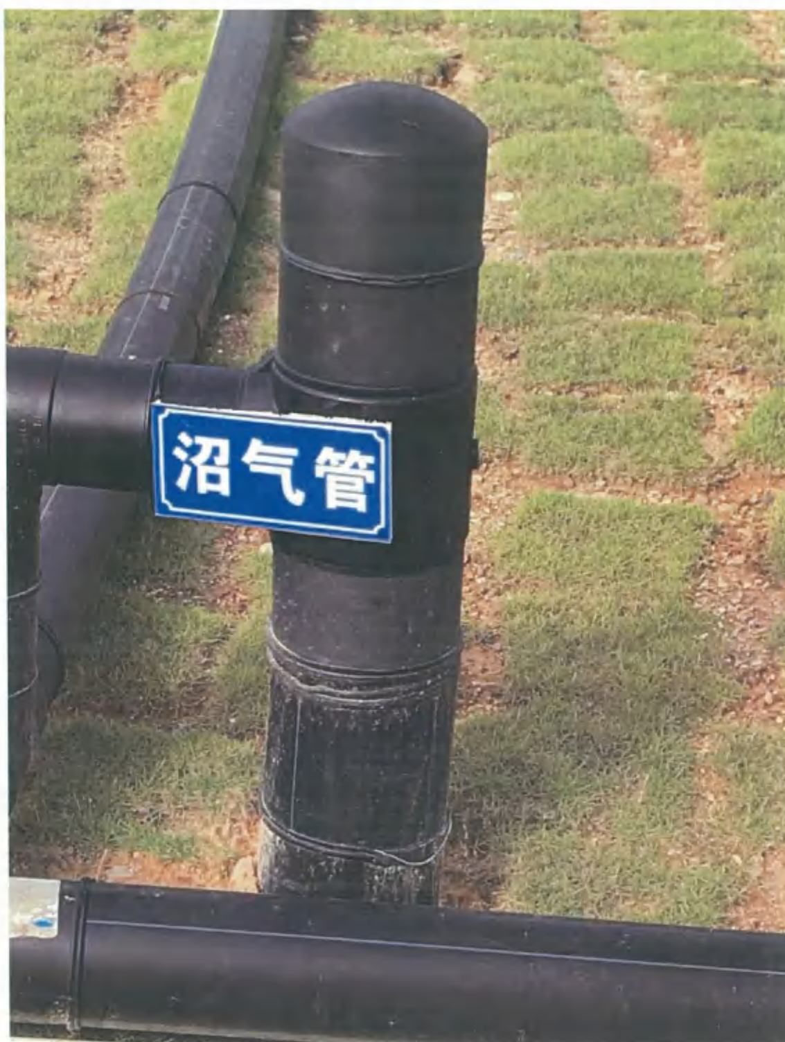
图 3-19 导气井建设完成
