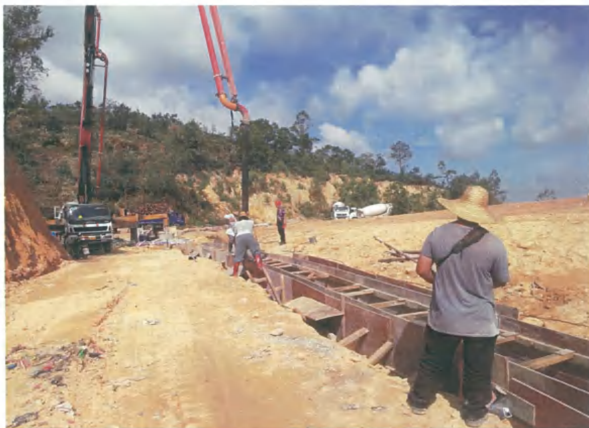
图 3-26 排水沟施工现场
