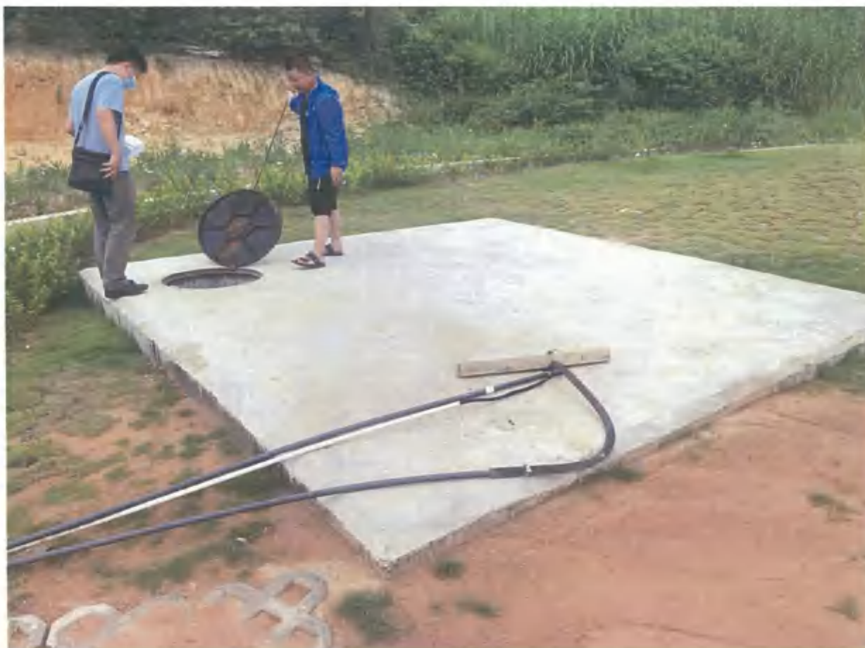
图 3-30 渗滤液收集池
