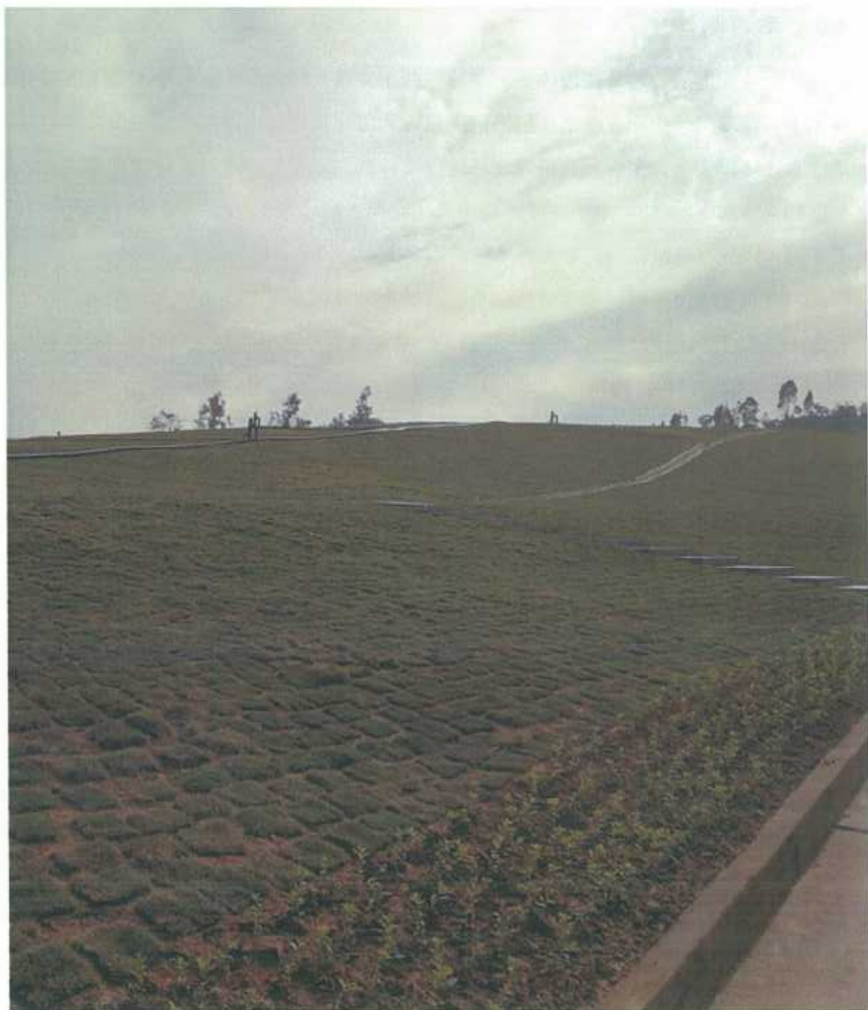
图 3-11 填埋区铺设植被层
