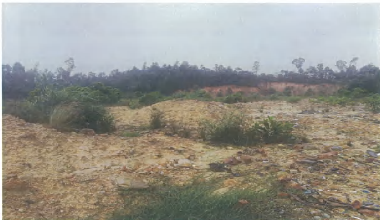
图 2-4 整改前填埋场南侧主填埋区现状图
