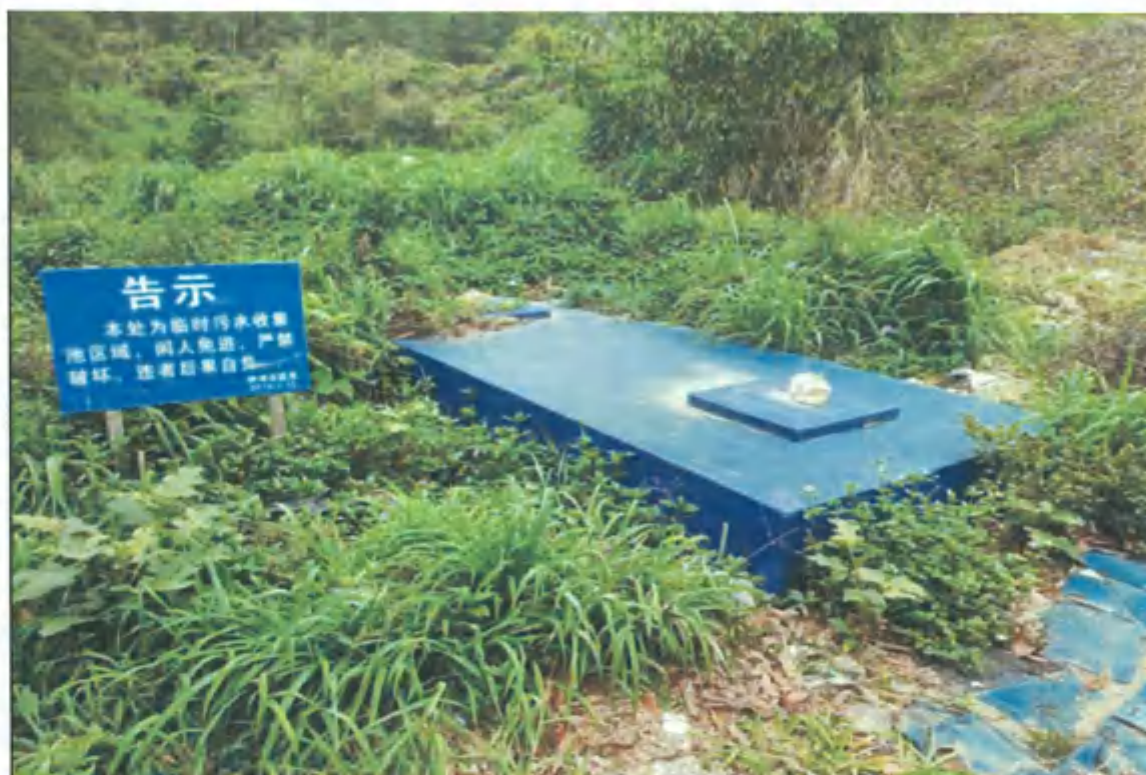
图 2-2 整改前填埋场临时渗滤液收集池
