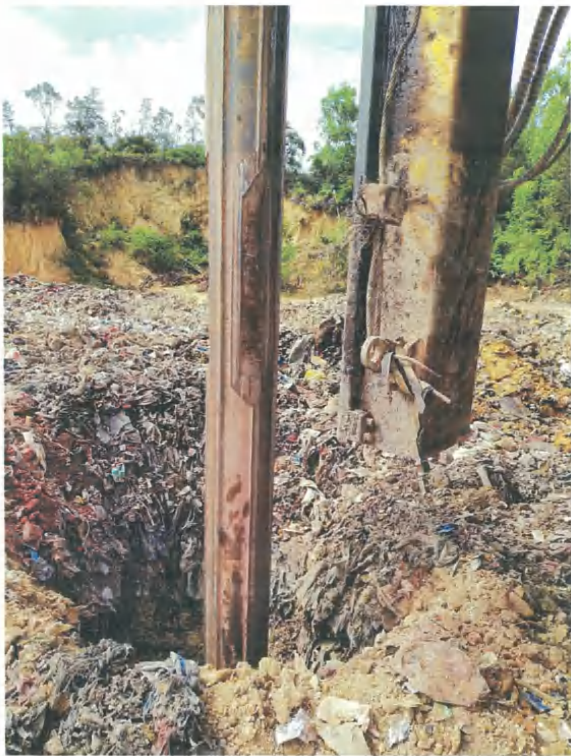
图 3-18 施工建设导气井
