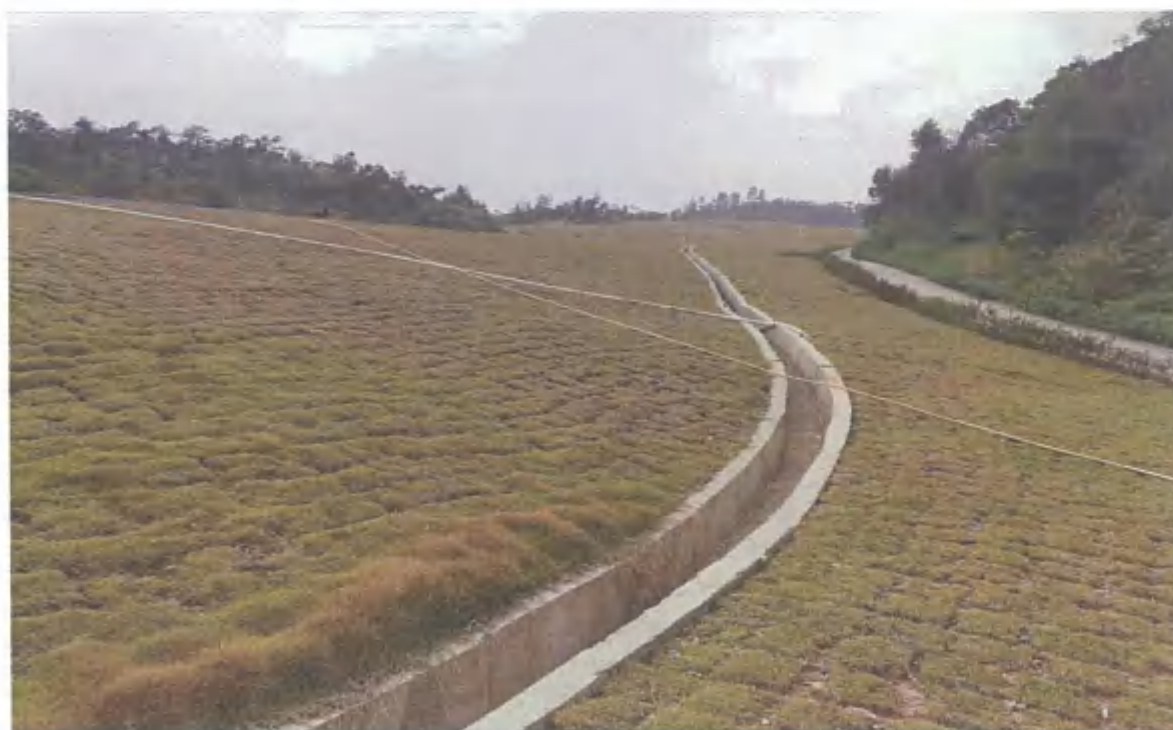
图 3-27 排水沟建设完成
