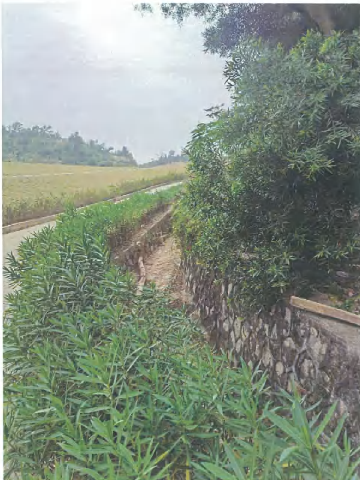
图 3-28 截洪沟建设完成
