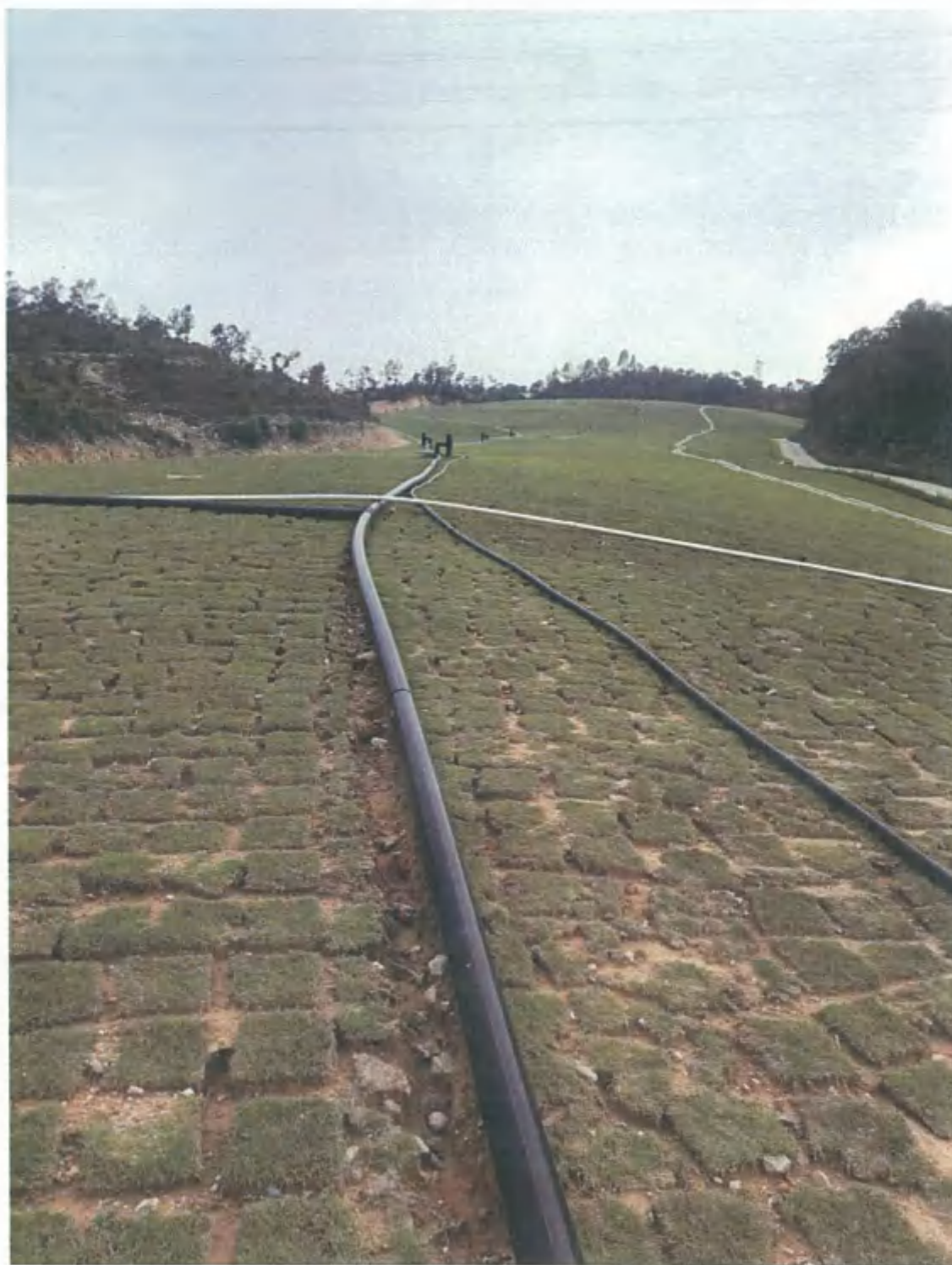
图 3-20 填埋气输送管道建设完成
