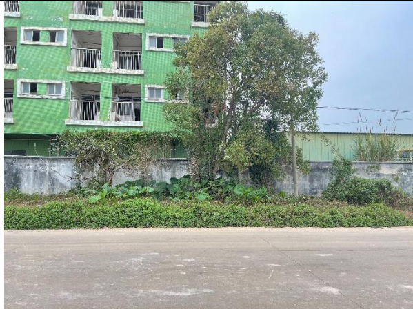
项目西南侧现状
