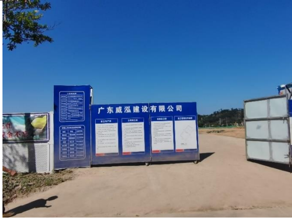
施工主要出入口（依托页岩砌块 B 区生产项目）
