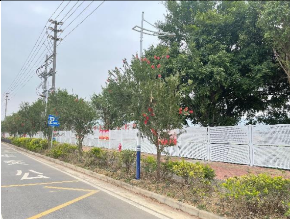
项目西北侧围蔽现状
