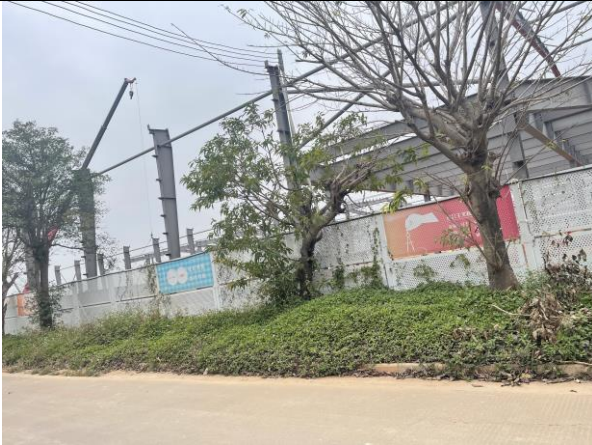
项目东南侧围蔽现状（依托页岩砌块 B 区生产项目）
