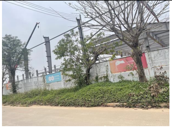
项目东北侧围蔽现状
