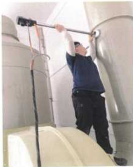
垃圾停放、倾倒、压缩和运输 过程废气处理前采样口
