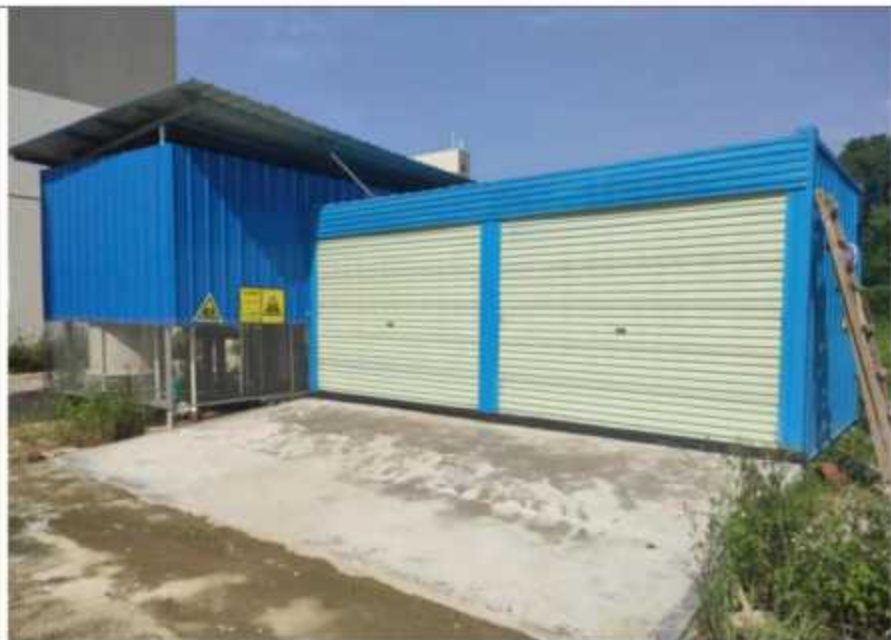
图 1 危废仓外部照片
