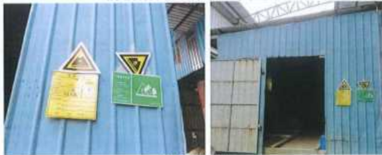
危废暂存间照片
