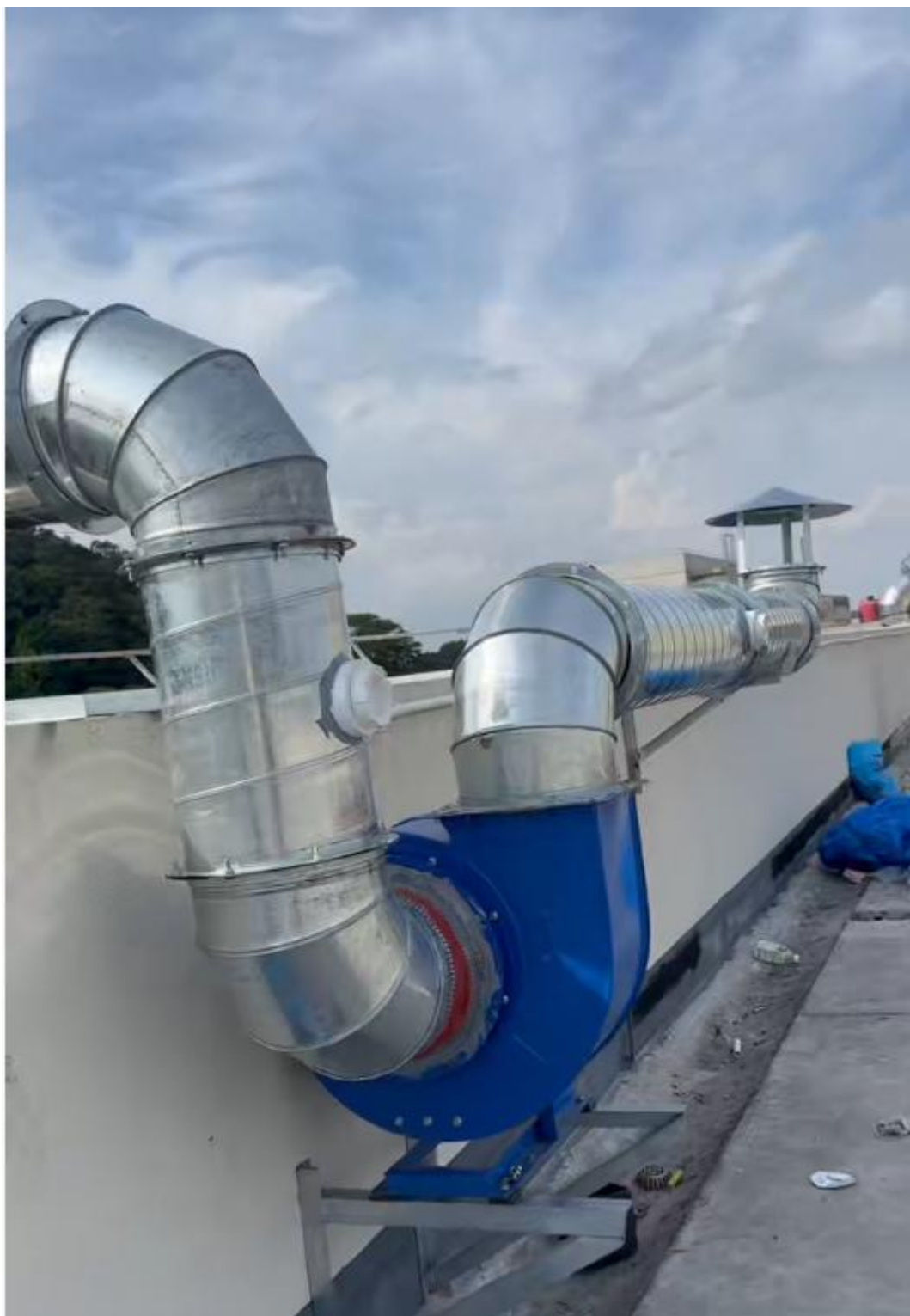
图 1 贴合、封胶废气设施 G1
