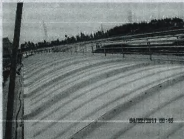
图 4-5 拱形玻璃钢盖板结构和密封实例照片 02
