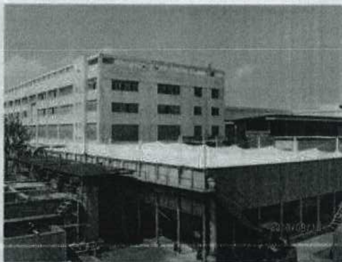
图 4-11 反吊氟碳纤维膜密封工程实例照片 03
