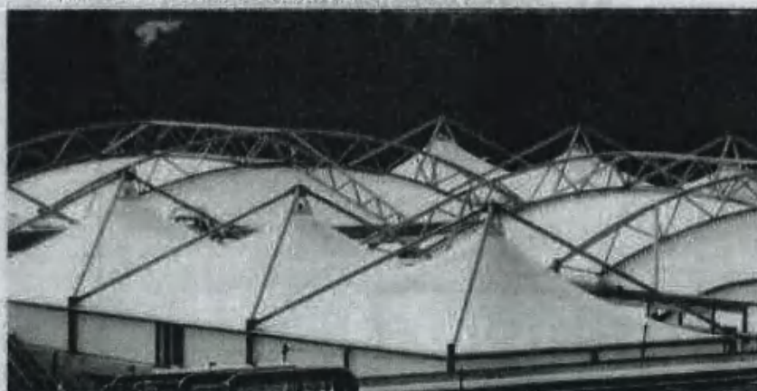
下图是我方本项目中调节池拟采用的密封方式的工程实例图:
