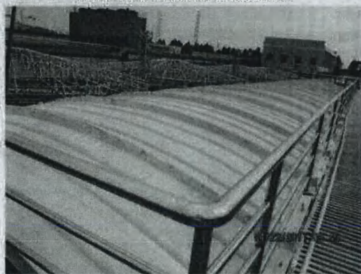
图 4-6 拱形玻璃钢盖板结构和密封实例照片 03
