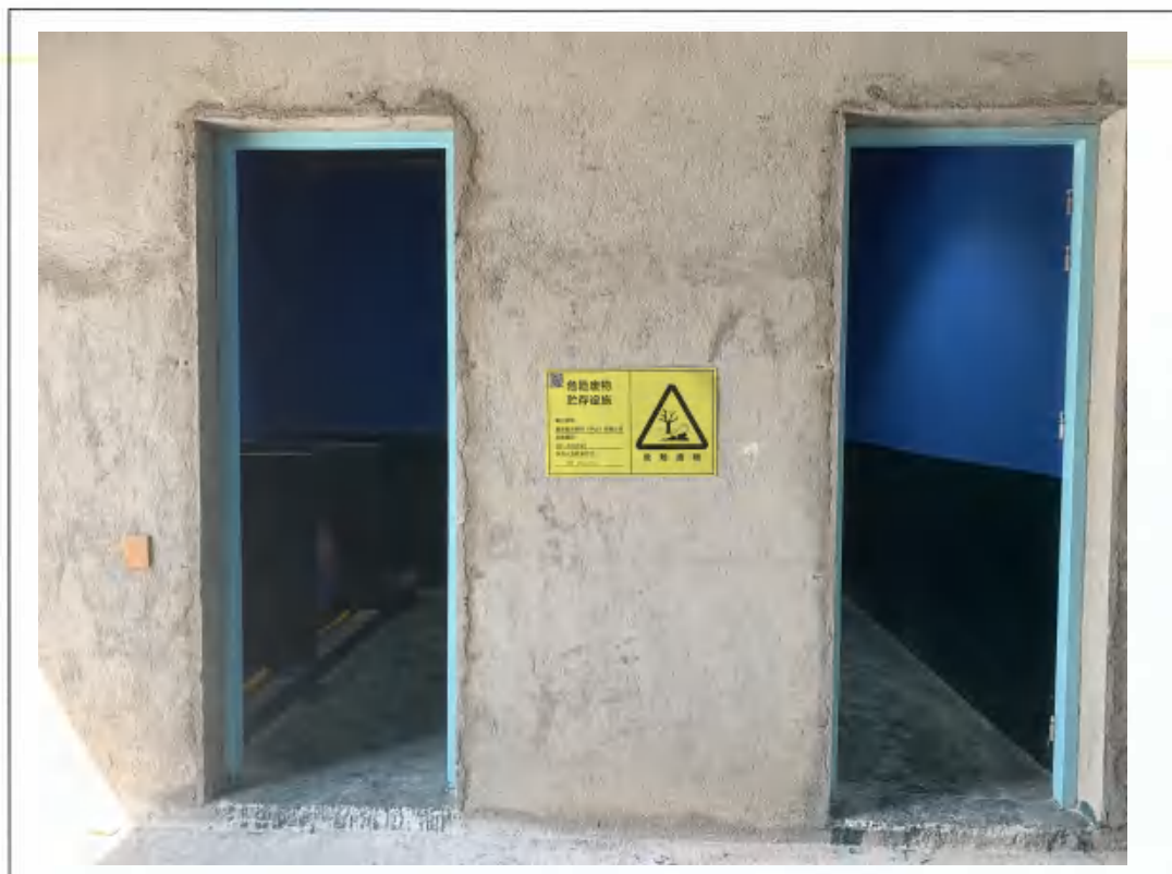
附图 4：危废暂存间图片
