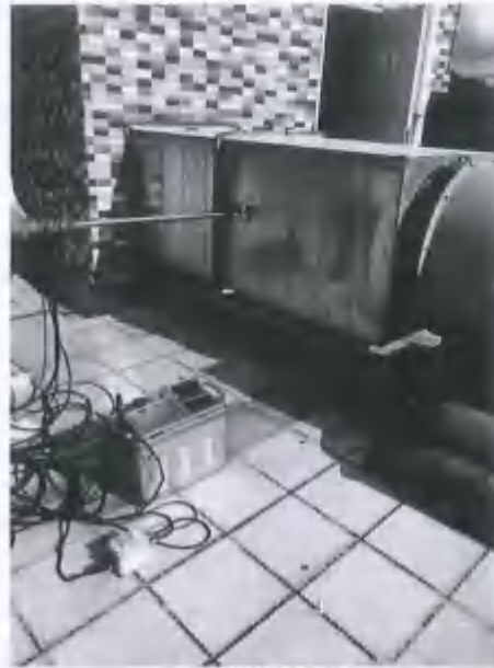
发电机废气排气筒
