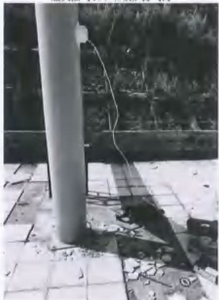
污水处理站处理后排放口
