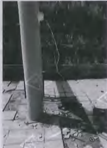
污水处理站处理后排放口
