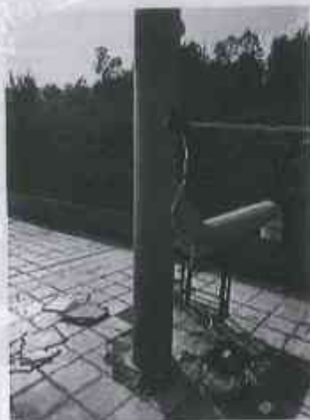
污水处理站出水处原水排放口
