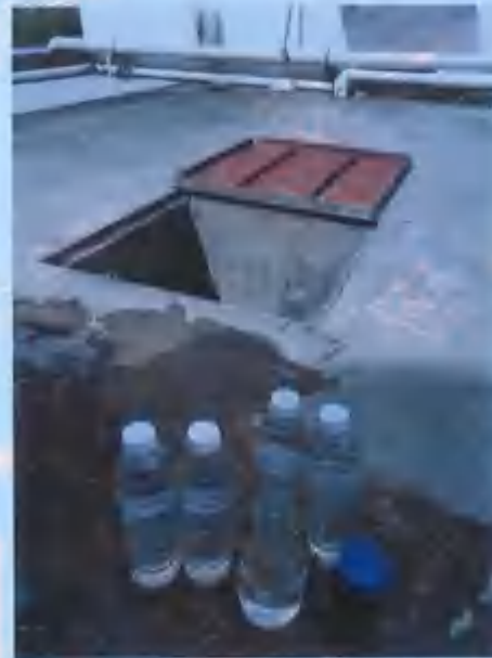
综合废水排放口
