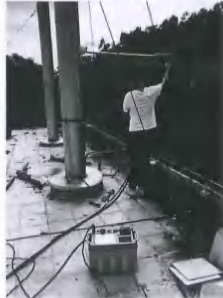
燃天然气2#锅炉排气筒
