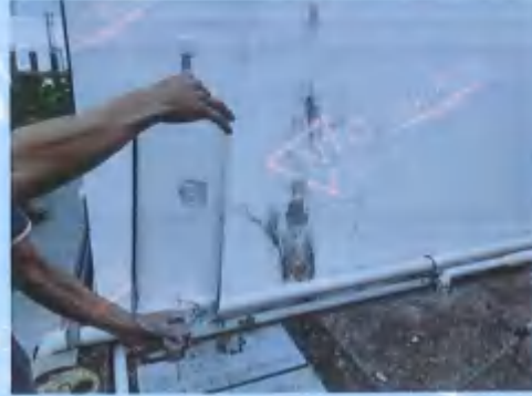
污水处理站厂界无组织下风向监控点 4#
