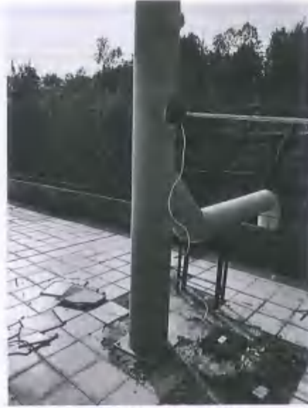
污水处理站烟囱处理后排放口
