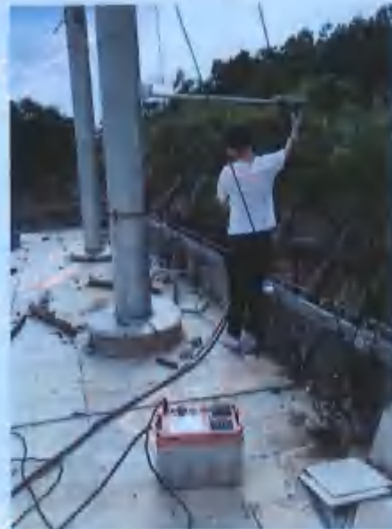
燃天然气2#锅炉排气筒
